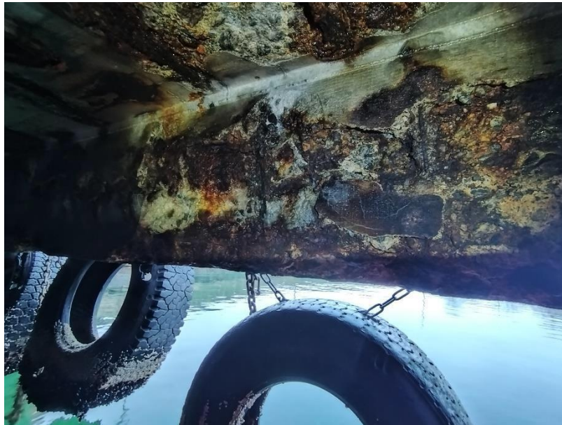
Figur 7. Tilstand fenderskjørt
