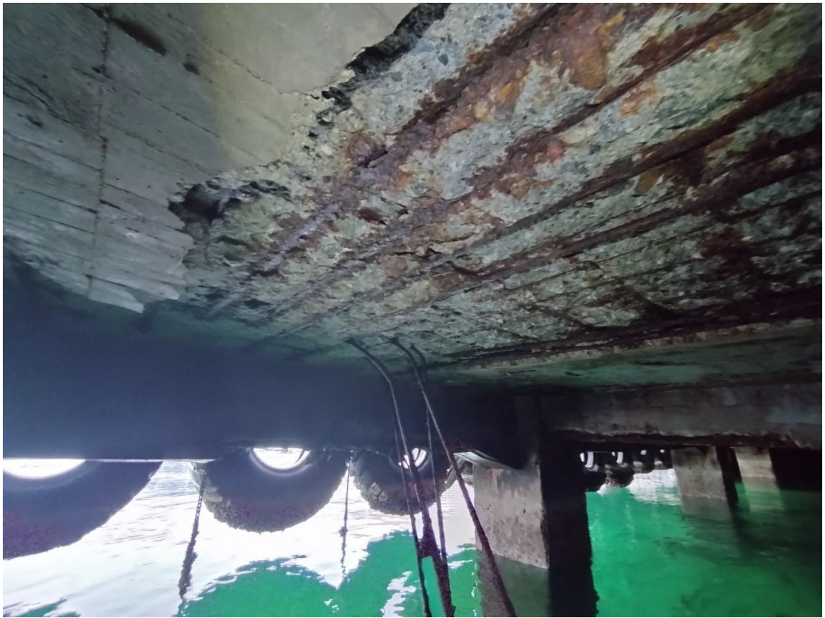
Figur 8. Tilstand underkantarmoring – rustet over eller vesentlig tverrsnitt reduksjon.
