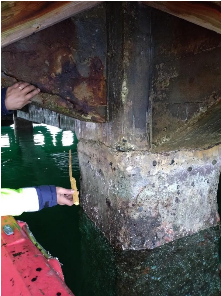
Figur 11. Typisk tilstand betongsøyle
