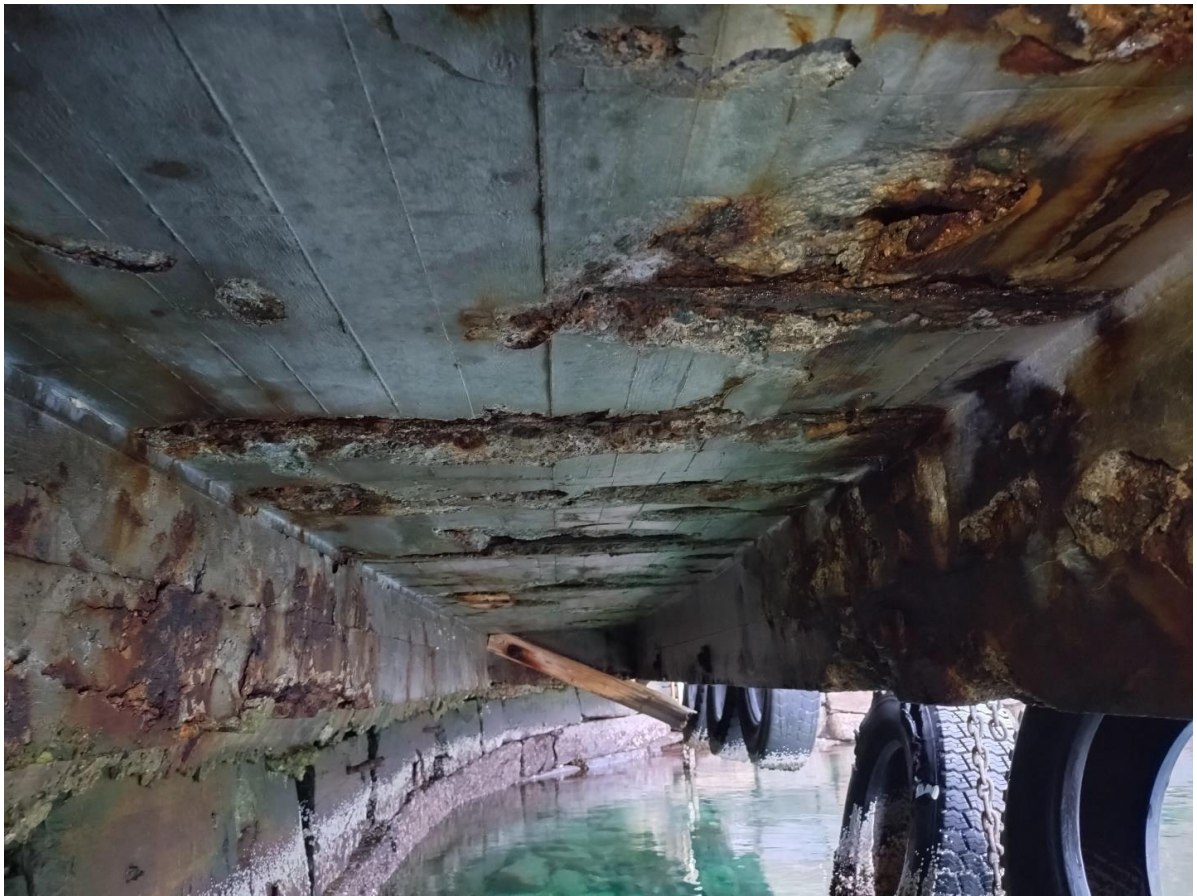
Figur 12. Typisk tilstand nordside utkraget 160cm
